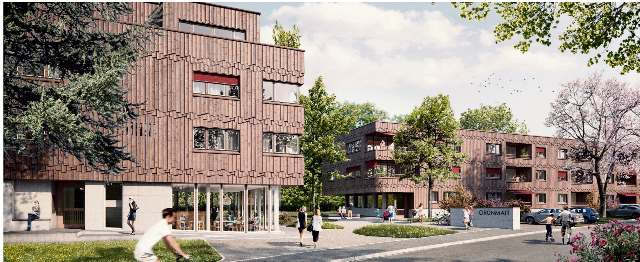
Visualisierte Ansicht der Überbauung Grünmatt, Grünmattstrasse 1, 8405 Winterthur
